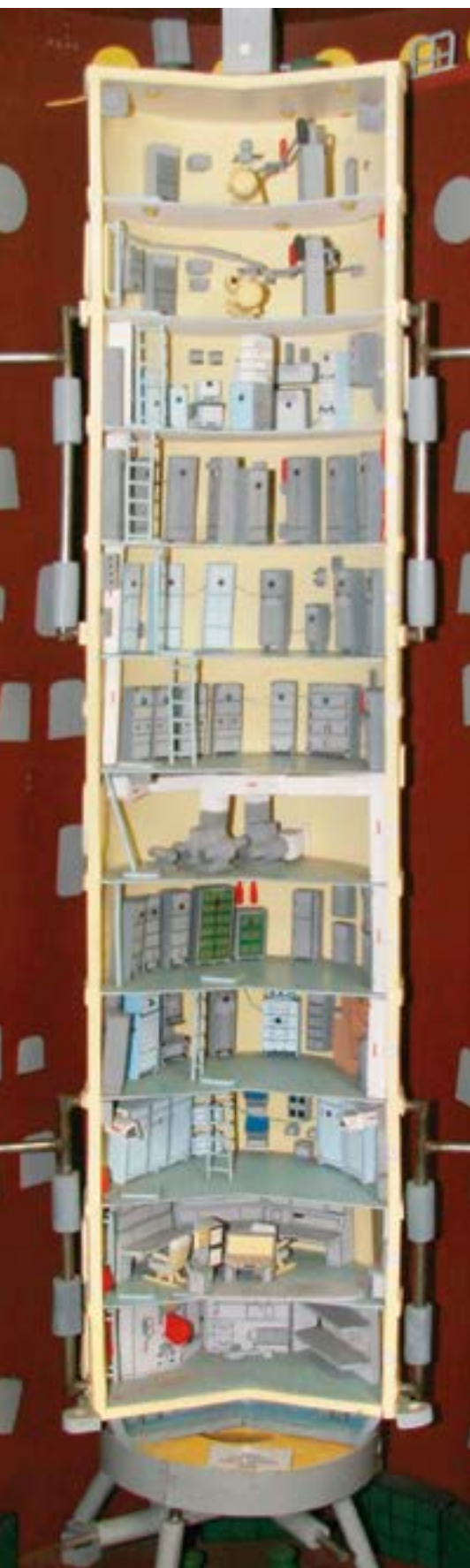
Макет унифицированного командного пункта в разрезе. По сути это размещенная под землей 12-этажная башня на гидравлической подвеске. Глубина шахты — 45 м, диаметр — 6 м. Длина контейнера КП составляла 33 м, ширина — 3,3 м, вес — 125 т
